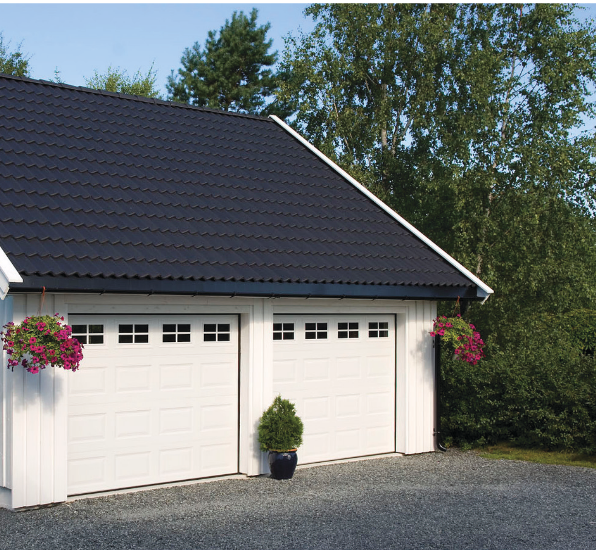
Kassett , vindu med kryss-sprosser.
